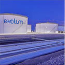
Exolum ha conseguido transportar con éxito hidrógeno en forma de portadores líquidos orgánicos (LOHC, por sus siglas en inglés) a través de su red habitual de oleoductos. Concretamente, se transportaron 400.000 litros de LOHC a través de la infraestructura existente desde la instalación de almacenamiento de Bilbao hasta la de Burgos, por una tubería de 14" de diámetro y más de 192 kilómetros de longitud.
